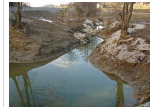
Neu geschaffener Altarmbereich im Rohzustand
