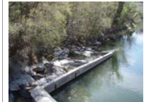
Neuer Fischaufstieg beim Kraftwerk in Peggau
