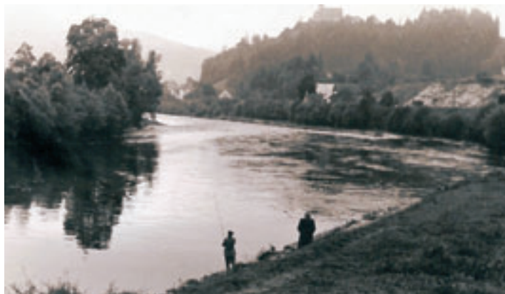
Blick auf den Bereich um das KW-Peggau 1954 flussabwärts
