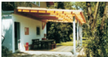
Schutz vor Witterung: das neue Vordach
