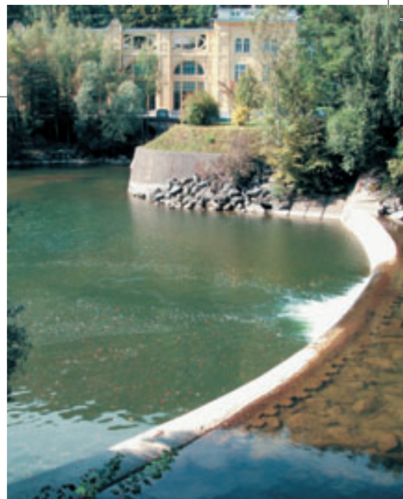
Die Betonschwelle beim Kraftwerk Peggau
