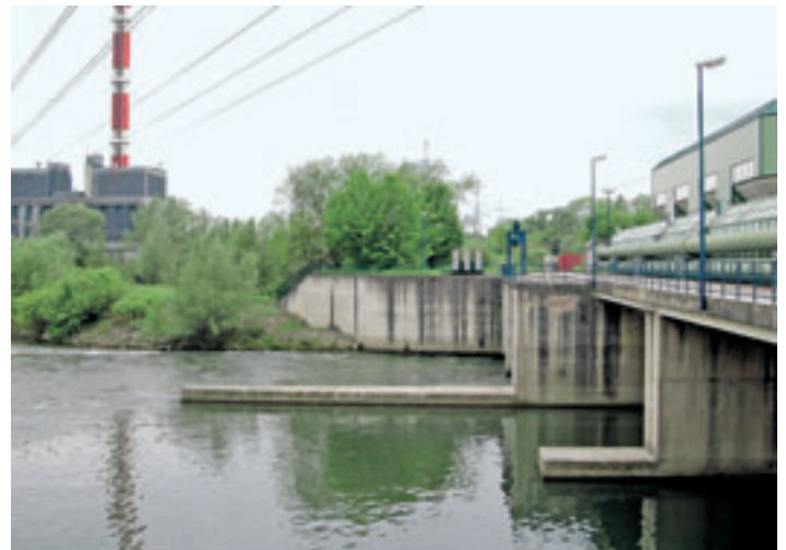
Tipp für den Kraftwerksbereich: Grundfischen auf Aalruten
