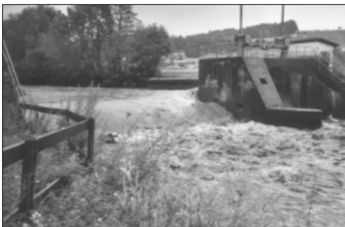
Krasse Unterschiede: das alte Krottendorfer Wehr bei Hochwasser ...
