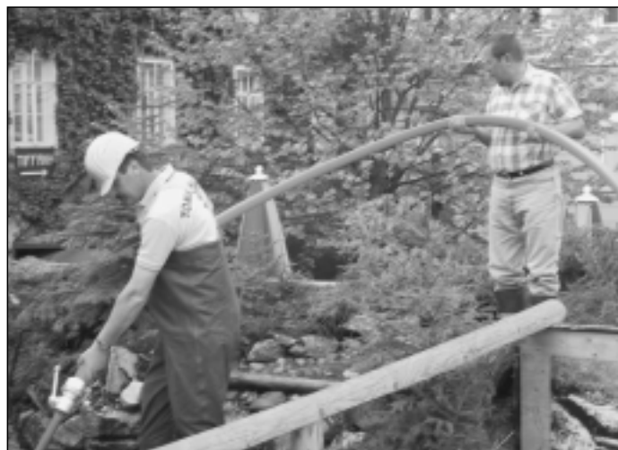
Alfred Kraus und Vinzenz Potocnik bei Reinigungsarbeiten ....
