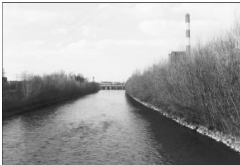
Bild oben: Monotone Unterwasserstrecke des KW Mellach – ein dringender Fall für Strukturierungsmaßnahmen.
